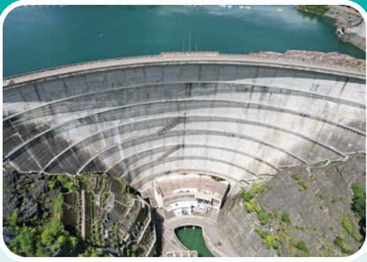
ながわど 奈川渡ダム あずみ 安曇発電所(長野県)
