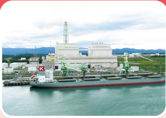
はらまち 原町火力発電所 (福島県) ふくしまけん
